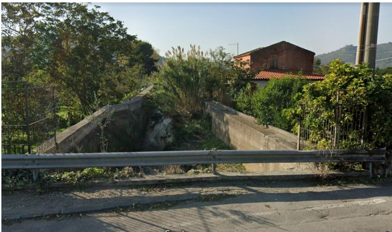
Tipicamente gli argini del Torrente Solofrana sono stati costruiti in mattoni di roccia tufacea, nel corso degli anni sono stati fatti dei lavori di innalzamento della sezione idraulica che hanno comportato una defluizione delle acque a valle in modo più veloce ma restringimenti e allargamenti del
