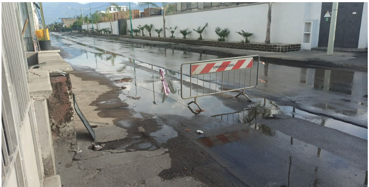
Strada allagata in Via Nuova San Marzano e Via Lo Porto in Scafati (Sa)
