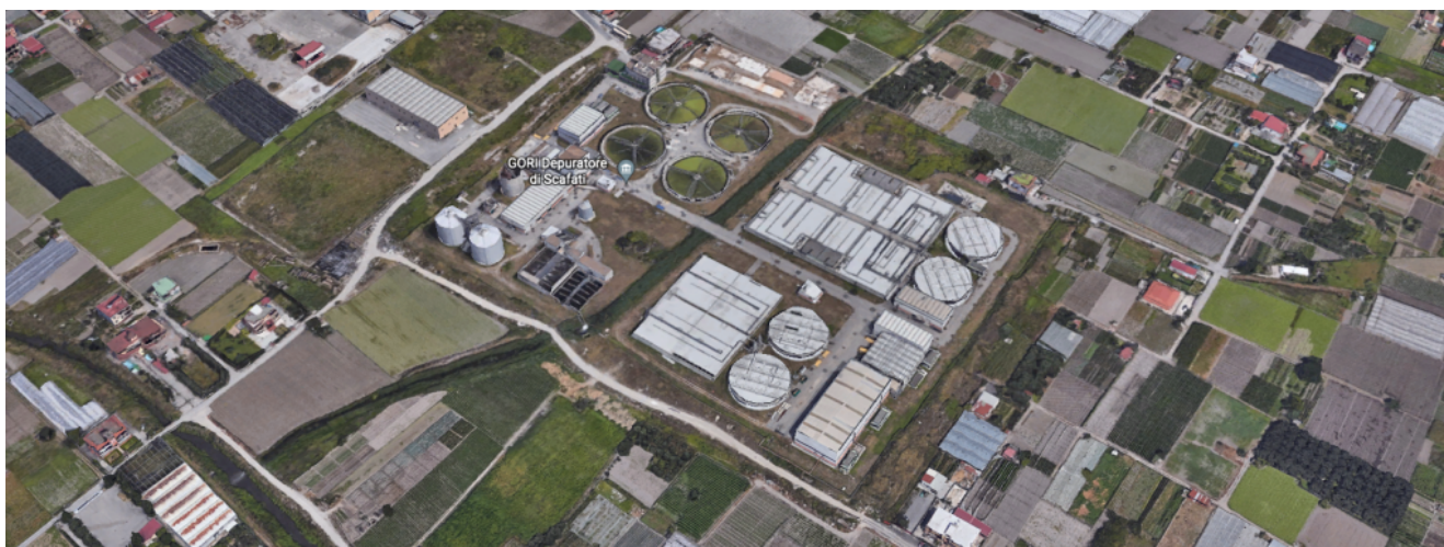
Depuratore di Scafati
