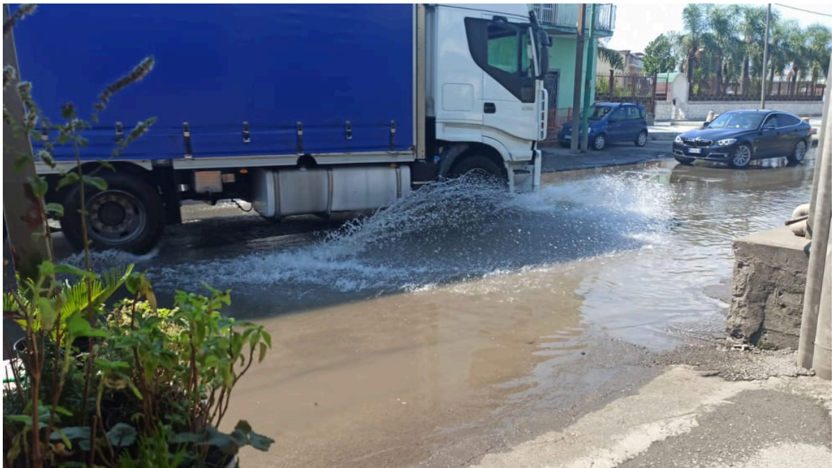
Strada allagata in Via Nuova San Marzano e Via Lo Porto in Scafati (Sa)
