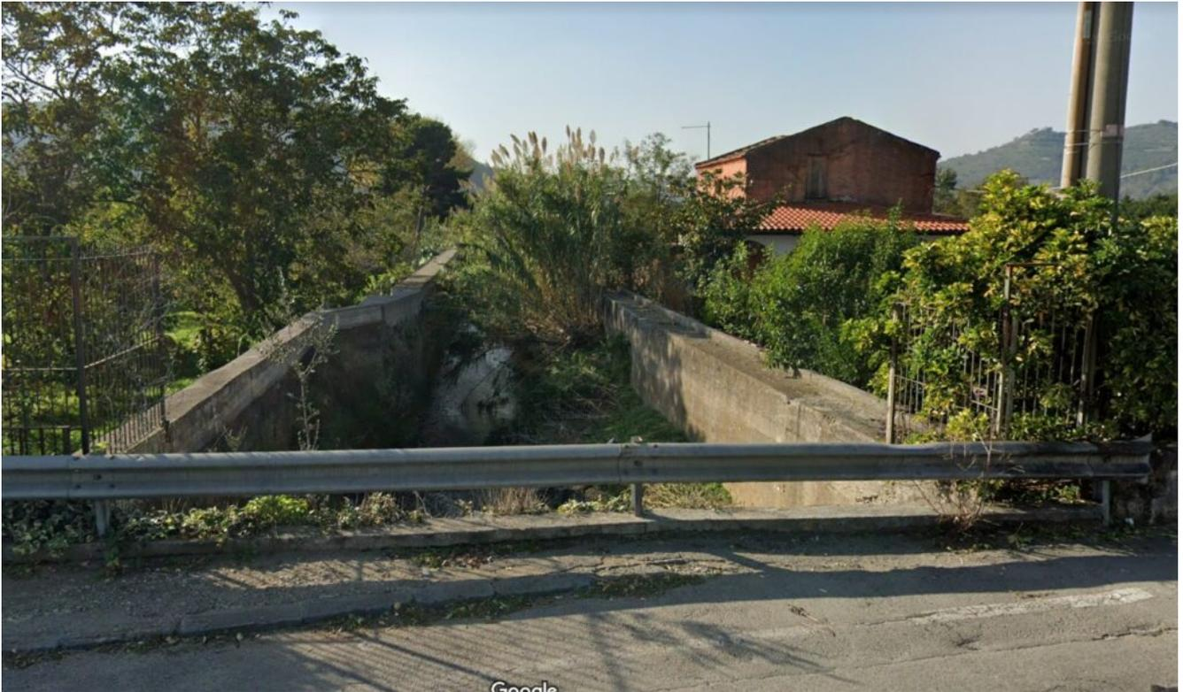
Tipicamente gli argini del Torrente Solofrana sono stati costruiti in mattoni di roccia tufacea, nel corso degli anni sono stati fatti dei lavori di innalzamento della sezione idraulica che hanno comportato una defluizione delle acque a valle in modo più veloce ma restringimenti e allargamenti del corso d'acqua.
