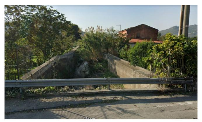
Tipicamente gli argini del Torrente Solofrana sono stati costruiti in mattoni di roccia tufacea, nel corso degli anni sono stati fatti dei lavori di innalzamento della sezione idraulica che hanno comportato una defluizione delle acque a valle in modo più veloce ma restringimenti e allargamenti del corso d'acqua.
