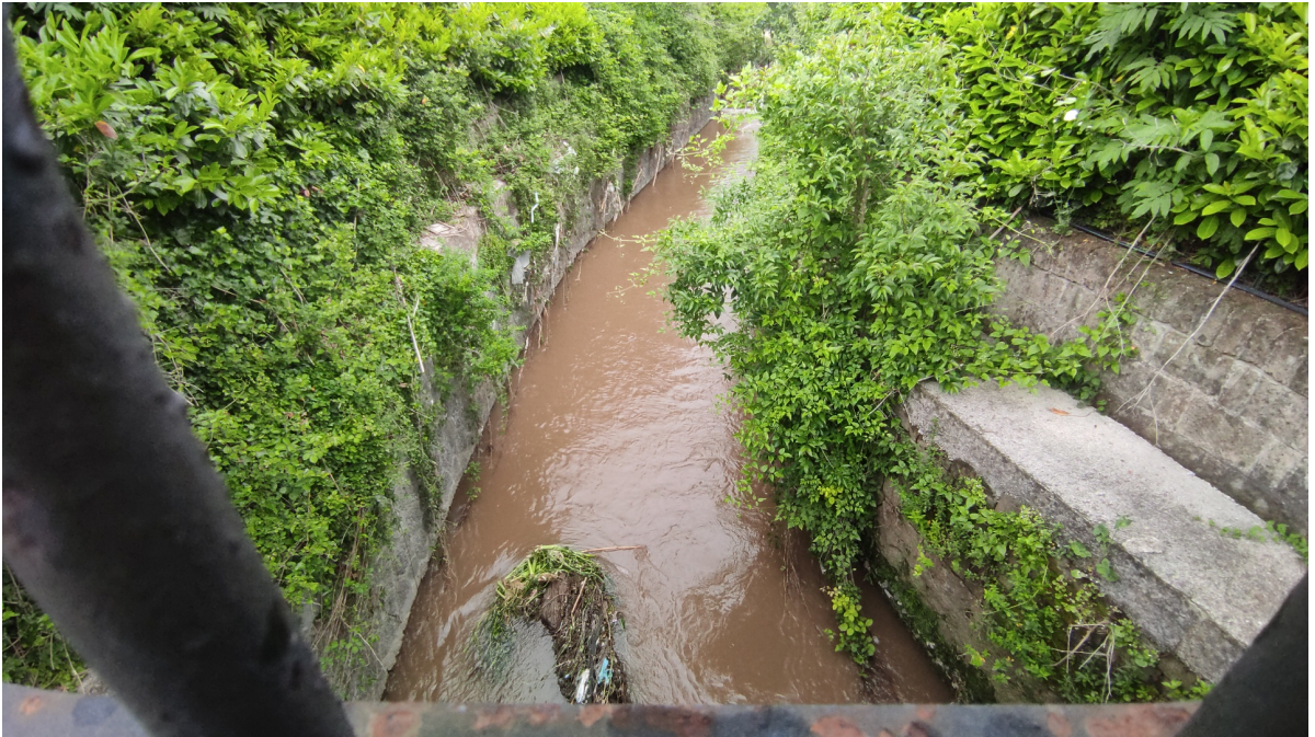
Torrente Solofrana in Mercato San Severino nella frazione di Pandola
