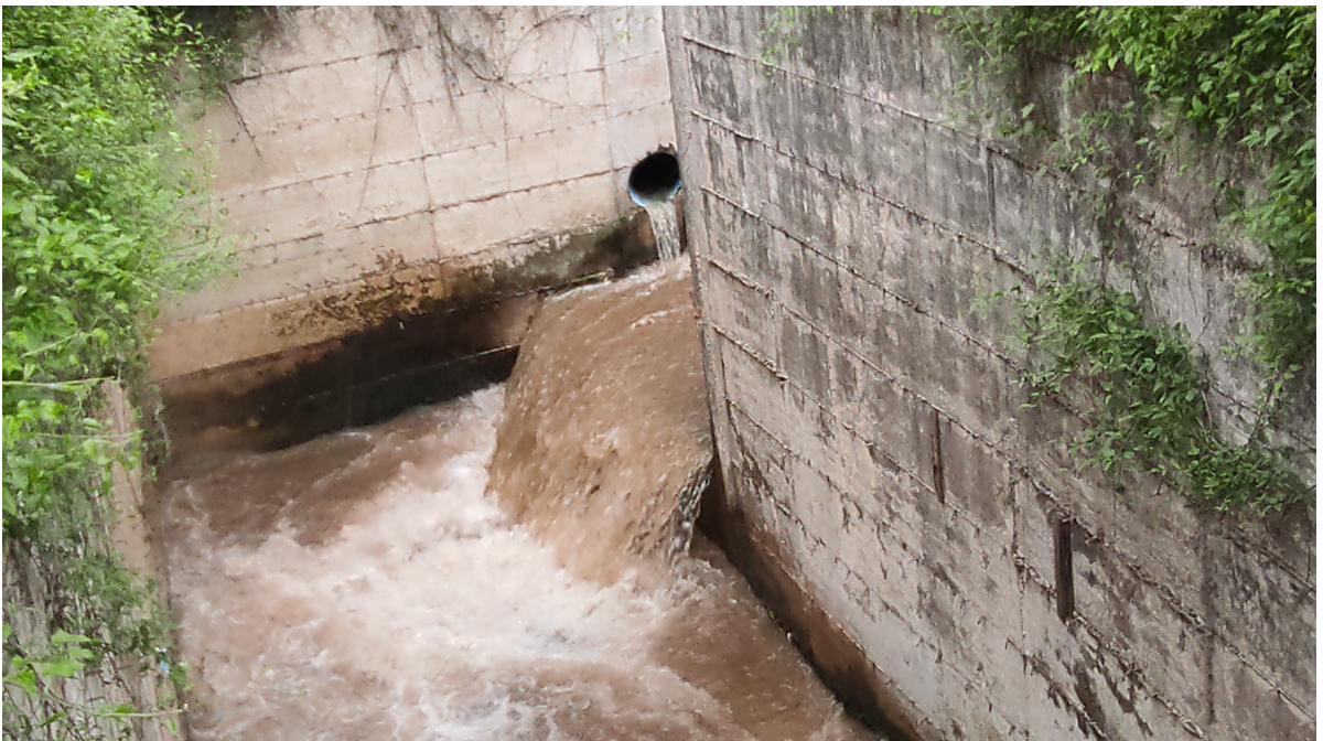
Fiumarello, affluente del Torrente Solofrana che sfocia nella Vasca di laminazione in Mercato San Severino denominata Vasca di laminazione Pandola
