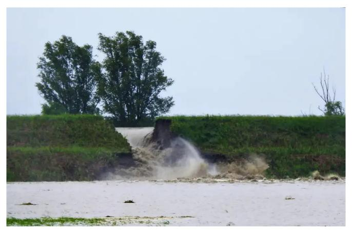
Rottura di un argine artificiale di un fiume pensile (Ravennate)
