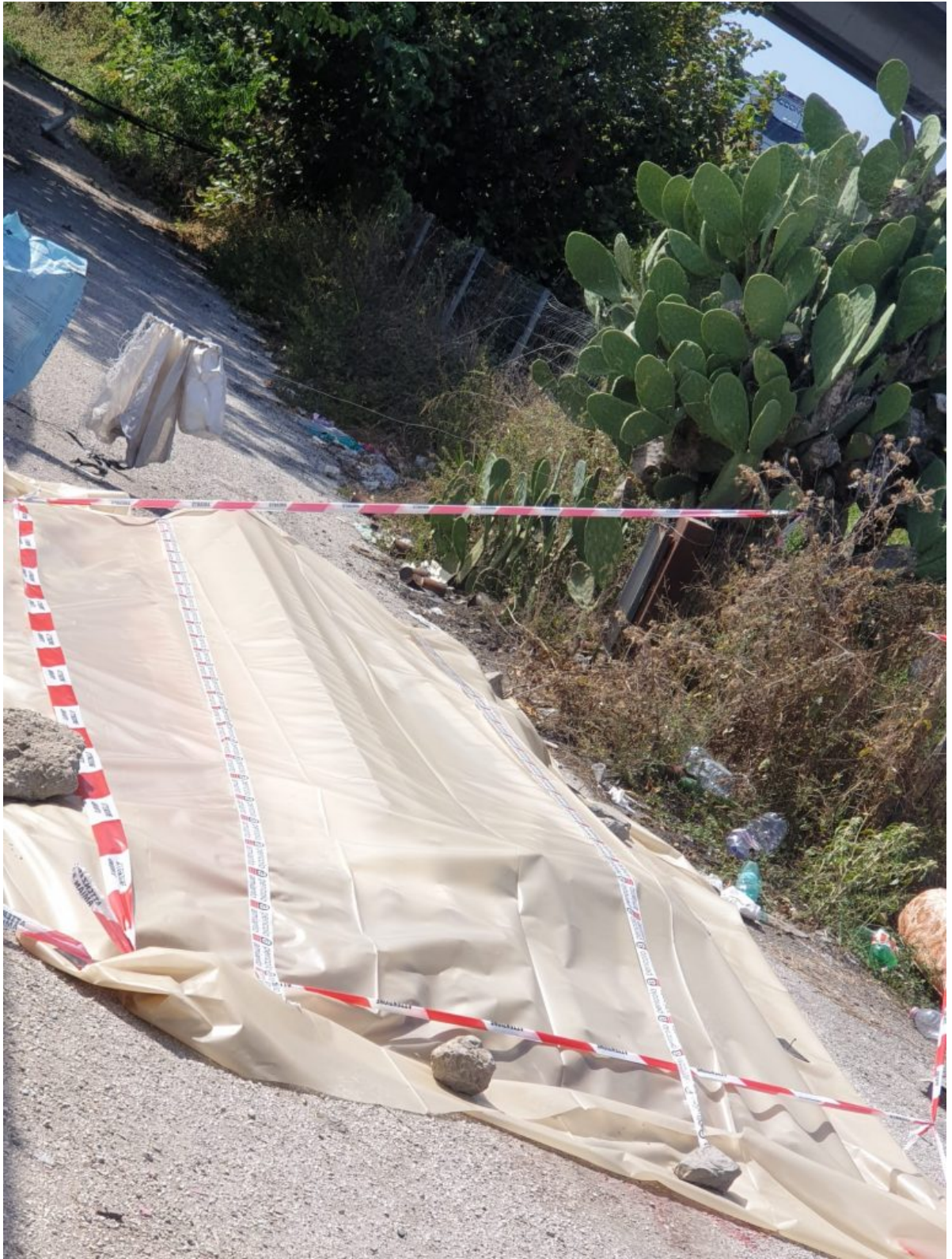
Intervento comune di Nocera Inferiore – Settore Ambiente
